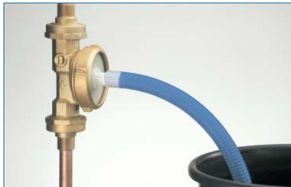
Bild 21: Entlüften mit dem VORTEX Entlüftungsflansch EF 150
