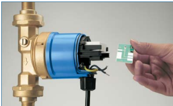
Bild 23: Austausch der Leiterplatte
