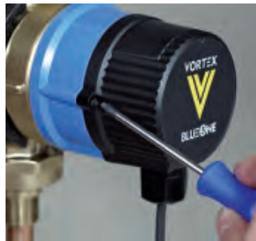
▲ Bild 13 • Die Montage der Anschlusskappen auf den Motor ist schnell, ohne Kraft und ohne Abrutschen des Schraubendrehers durchführbar. Die Verwendung von Innen-6-Rund-Schrauben macht dies möglich. Sie sollen gleichzeitig „Hobby-Handwerkern“ den Spaß am Manipulieren einschränken.
